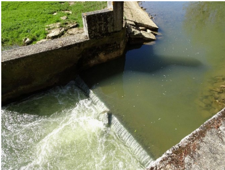
Figure 1 : Seuil de Bazoilles-sur-Meuse créant une discontinuité piscicole
