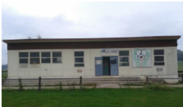
Les anciens vestiaires avant leur démolition
